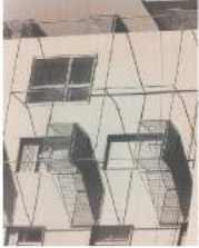
Das Stramböhl-Gestell, ein feingliedriges, sich über das gesamte Baufeld erstreckendes Stahlgerüst, das die unterschiedlichen Teile des Hauses wie Turm und Riegel zusammenbindet. Dieses Gestell umschliesst das Haus wie ein unregelmässig gespanntes Gewebe. An der Südfassade verdrängt es sich stark und bildet den Laubraum aus. Im Bereich des Turms formt es die Balkone und betont die Vertikale der dazwischenliegenden Treppentürme. Die feingliedrige Fassade verweist diese filigrane, offene Struktur weit über das Leben der Bewohner von Stramböhl gestalter – sie steht auch in bewusstem Gegensatz zu der eher flächigen Fassade mit Lochfenstern, welche Aussehen mit einem mineralischen Putz versehen wird. Das Zusammenfügen dieser beiden Gestaltungselemente erlaubt es Stramböhl auf die unterschiedlichen räumlichen Anforderungen zu reagieren und gleichzeitig als prägnante Figur im Wärmebildareal zu erscheinen.
